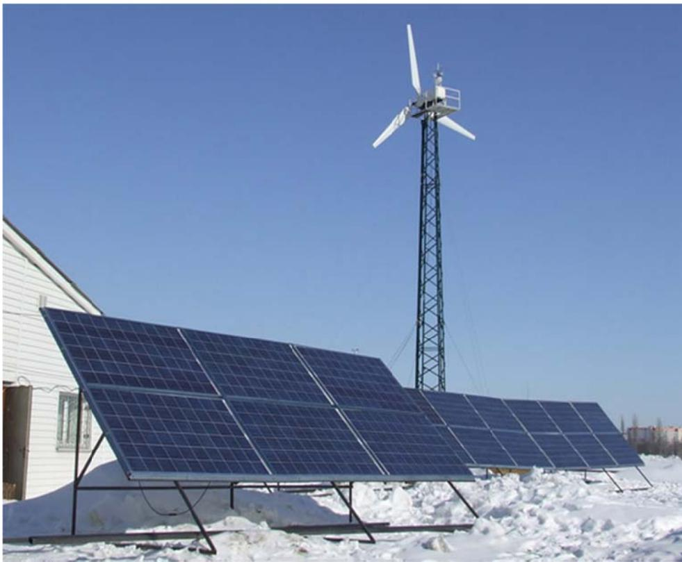
Рисунок 2 – Ветро-солнечная электростанция в Арктике
