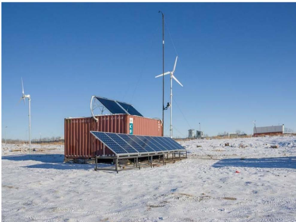
Рисунок 3 – Автономные гибридные электростанции контейнерного исполнения «КузбассСвязьРесурс»
