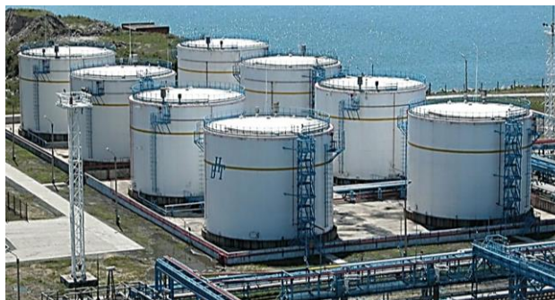
Рисунок 1 – Резервуары для хранения нефти и нефтепродуктов
