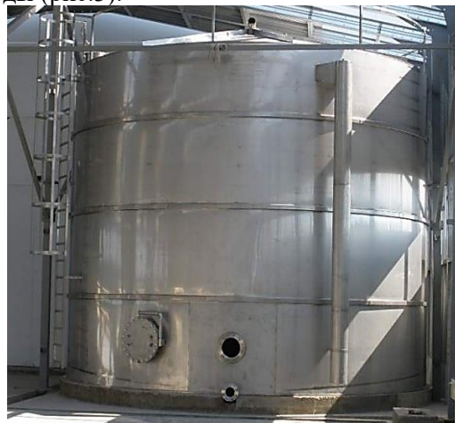
Рисунок 3 – Резервуар для хранения кислот
