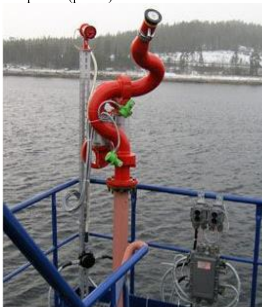
Рисунок 1 – Стационарный лафетный ствол на вышке [9]: ПЦН – погружной центробежный насос, В – вентиль, ПГ – пожарный гидрант с указанием диаметра, СЛС – стационарный лафетный ствол для подачи компактной водяной струи; H_j – глубина погружения, h_j – высота установки СЛС, L_i – длины участков нагнетательного трубопровода).
