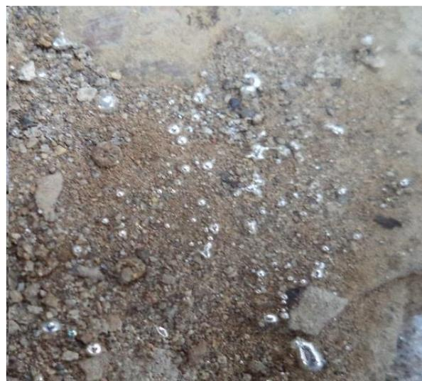
Рисунок 5 – Разрушенное цементное покрытие производственного цеха, который покрыт ртутными каплями, октябрь, 2018 г.
