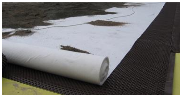
Рисунок 3 – Укладка геотекстиля
