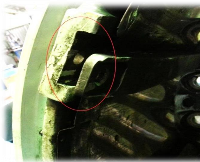
Рисунок 7 – Отсутствие металлической прокладки и болта крепления одной из направляющих тормоза [10]
